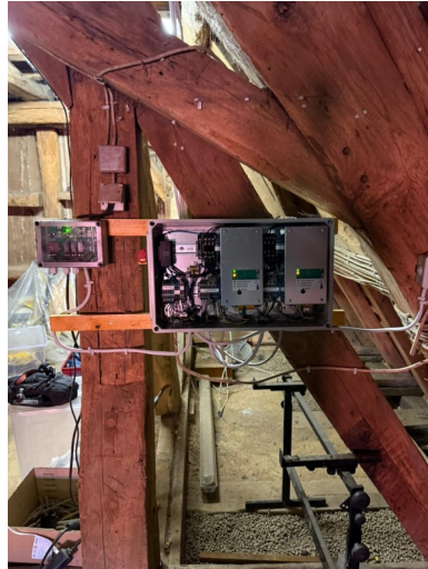
Die neue Elektrik für die beiden Glocken.
