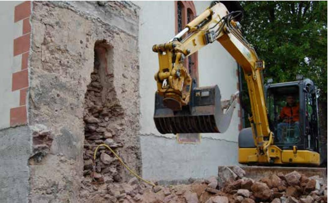
Um Voraussetzungen zum Anbau der Sakristei zu schaffen, musste der Stützpfeiler am südlichen Ende der Ostfassade der Burgkirche zurückgebaut werden. Die abgebrochenen Steine werden später wieder verwendet.
