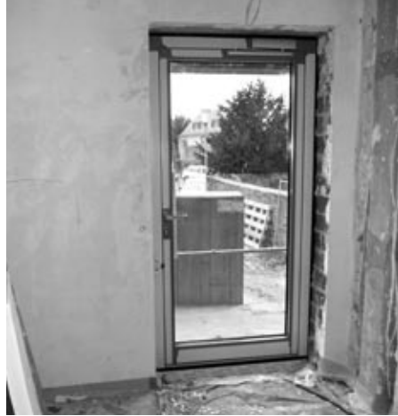
Die neue Tür nach draußen (aus dem ehemaligen Küsterhaus).
