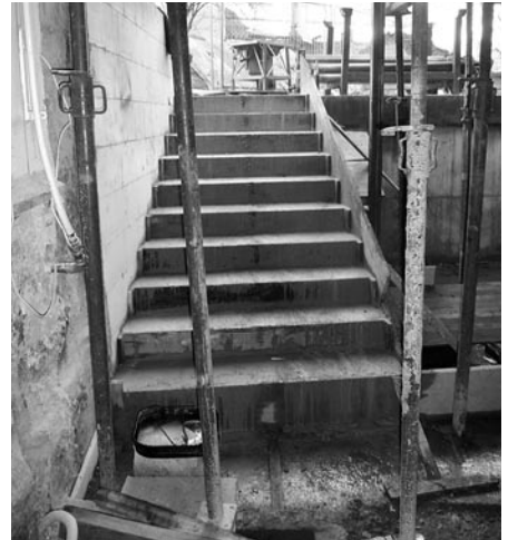
Die neue Treppe ins Untergeschoss ist gegossen
