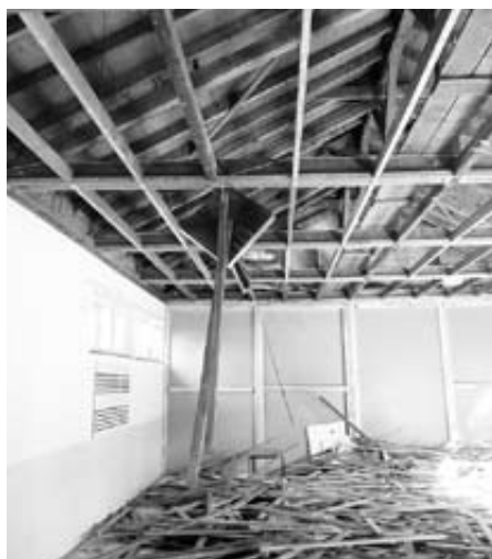
Saal ohne Deckenverkleidung.
