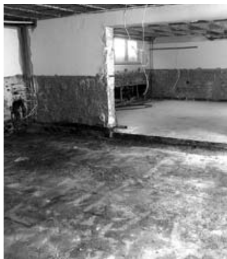
Das entkernte Untergeschoss.
