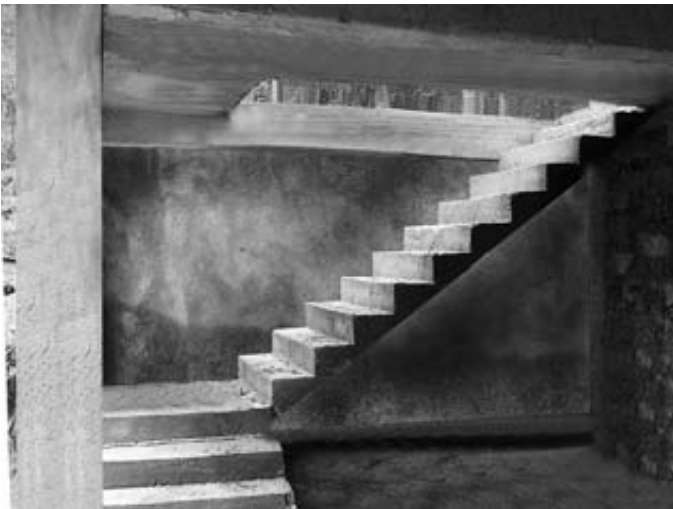
Treppenaufgang vom Stauraum zur Terrasse
