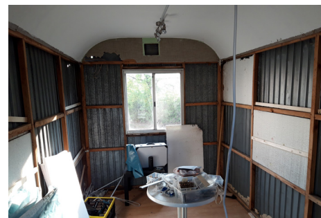
Am 15. April ging es los. Der Abriss der Wandplatten begann ...
