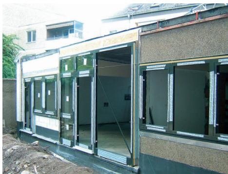
Mit dem neuen Küchenvorbau sind die Lücken, die mit dem Abriss entstanden sind wieder geschlossen, auf der anderen Seite ist der neue Gruppenraum an den Mehrzweckraum angebaut. Bis auf den Mehrzweckraum sind rundherum die neuen Fenster eingebaut. Das Gerüst, das
