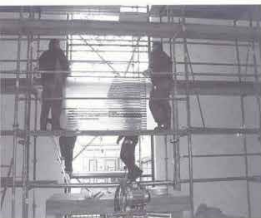
Arbeiten mit schwerem Gerät in der Kirche. Darunter: Einbau des neuen Kirchenfensters am 17. Februar 2006
