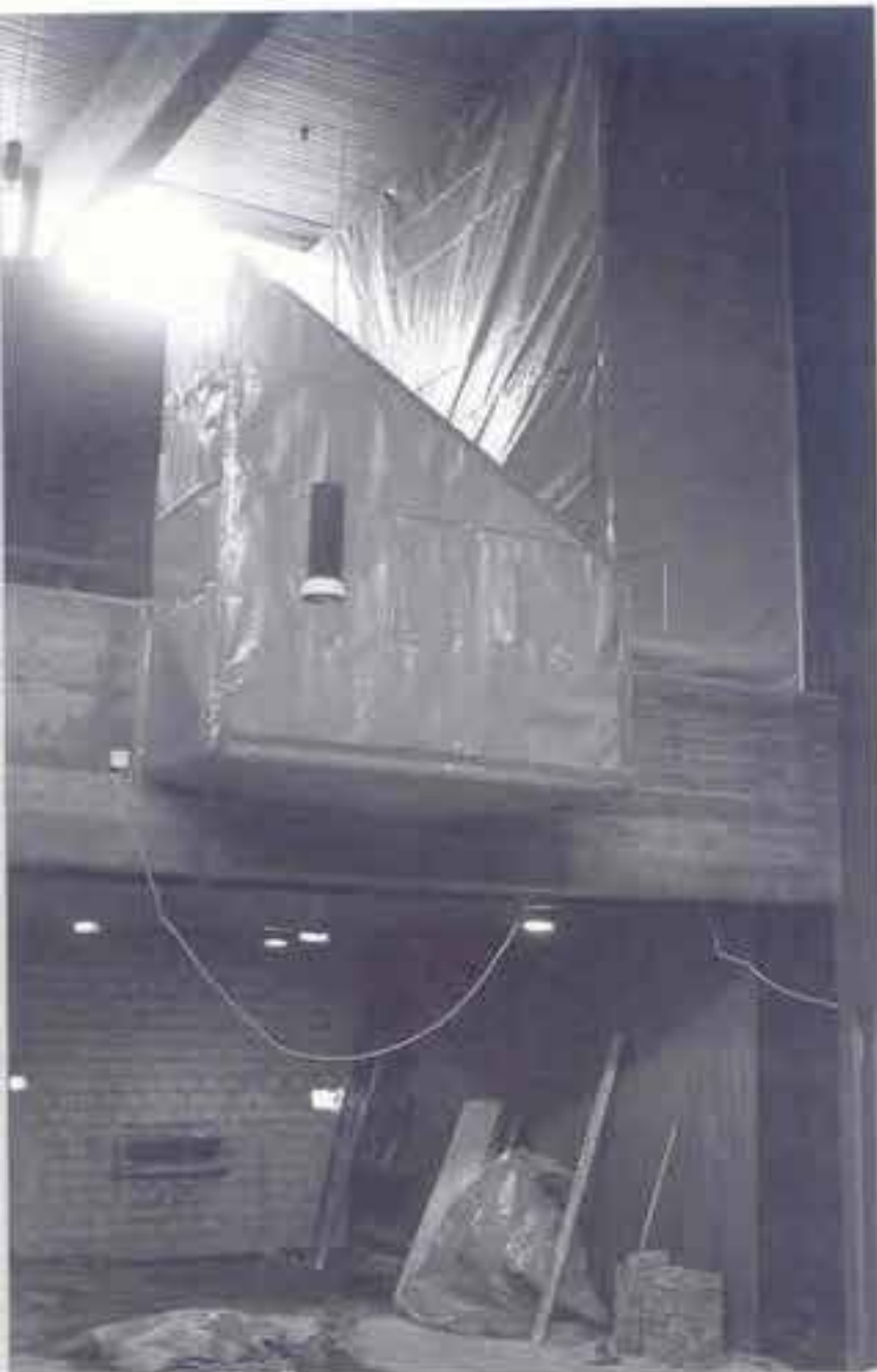
Innenansicht der Erlöserkirche während der Umbauarbeiten. Die Orgel wurde staubdicht verpackt.
