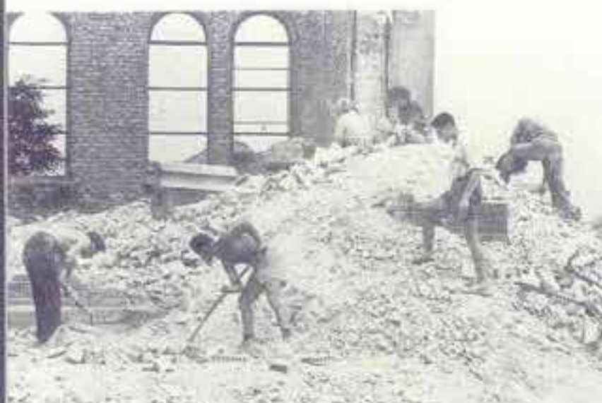
Nachdem beschlossen war, dass die Ruine der Kirche nicht mehr aufgebaut werden soll, wurde mit dem Abriss und dem Beseitigen des Schutts begonnen.
