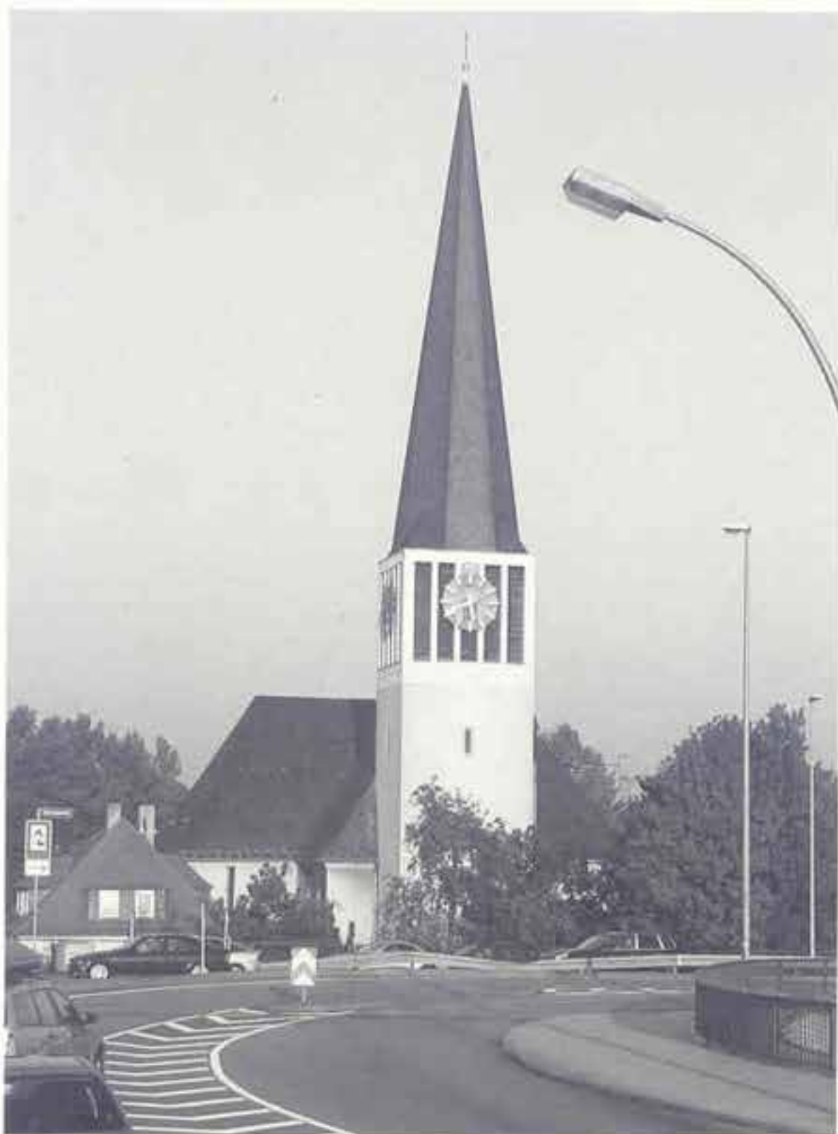
Die katholische St. Georgs-Kirche, von der Theodor-Heuß-Brücke aus gesehen.
