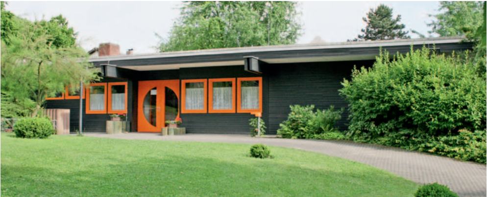
Kindergarten am Hemsberg erbaut 1975
