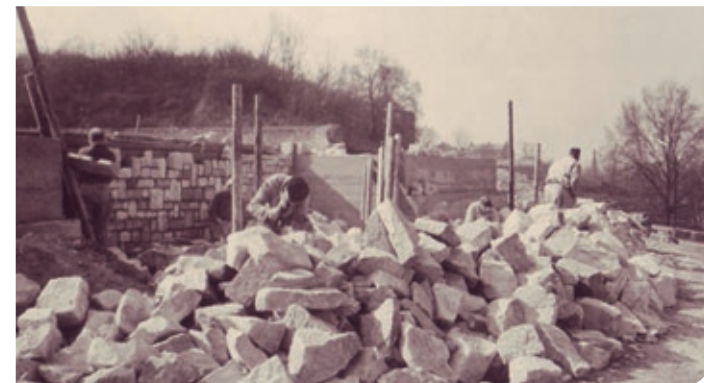
Mauerarbeiten, im Hintergrund rechts das Gelände der Zitadelle, Mitte links die alte Lampenfabrik in der Altstadt.
