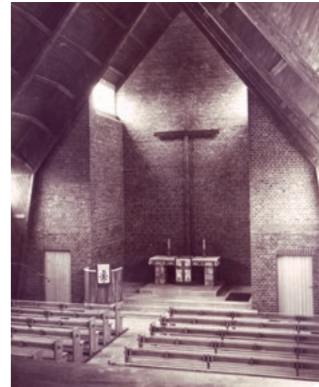
Die Lutherkirche 1949 Es fehlen noch einige Ausstattungsgegenstände: z. B. Liedtafeln und Taufstein.
