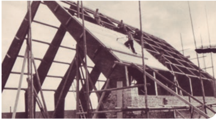
Nach den Plänen von Otto Bartning nimmt die Lutherkirche Gestalt an.
