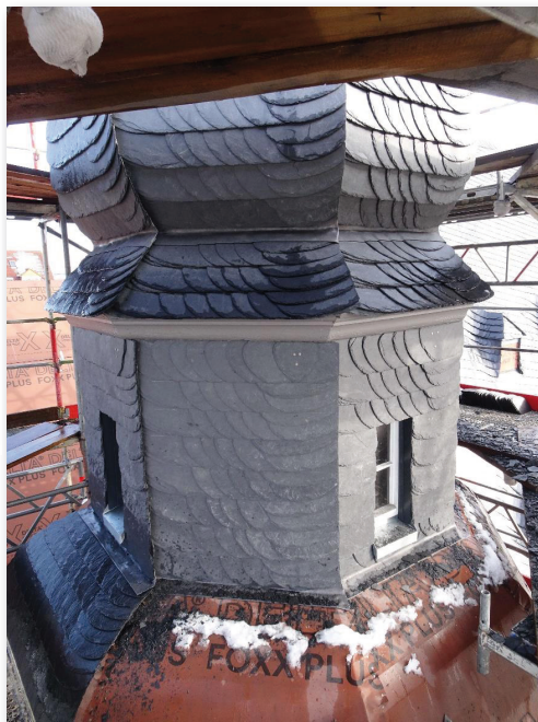
Schieferdeckungsarbeiten am Treppenturm, Anfang Feb. 2026
