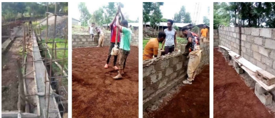
Baufortschritt an der Moroda Mosa Schule in Tokke Jawii
