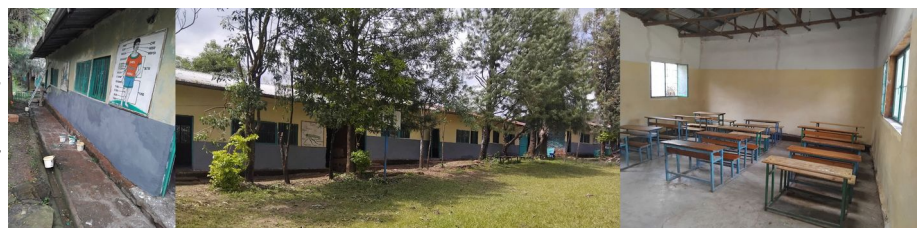
Instandsetzung nach dem "Termitenfraß"
