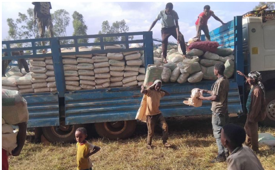
Zementlieferung für den Bau der Schule
