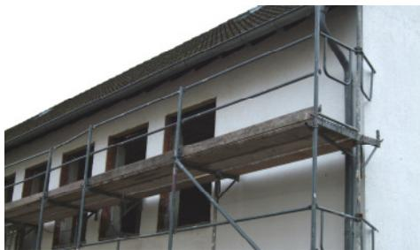
**Das Gerüst steht zum Auswechseln der Fenster und zur energetischen Sanierung der Außenmauern**
